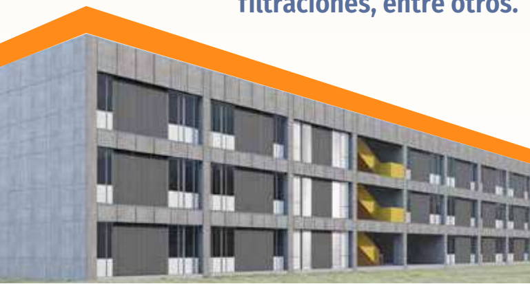
■ NÚCLEO sanitario del edificio H.
