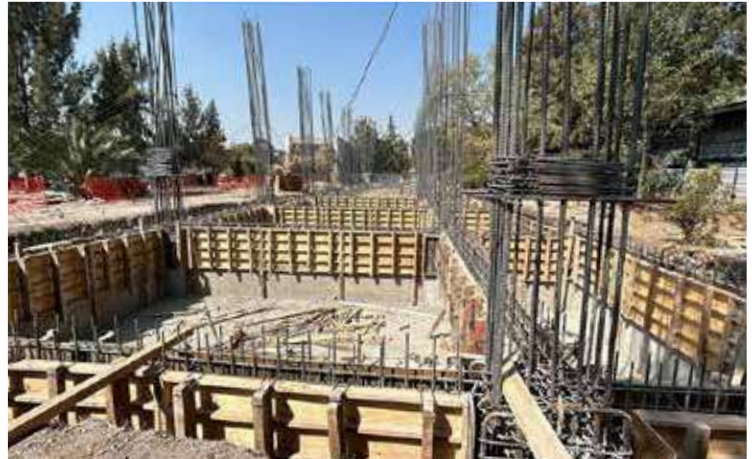
■ CONSTRUCCIÓN del edificio para los Laboratorios Curriculares.
