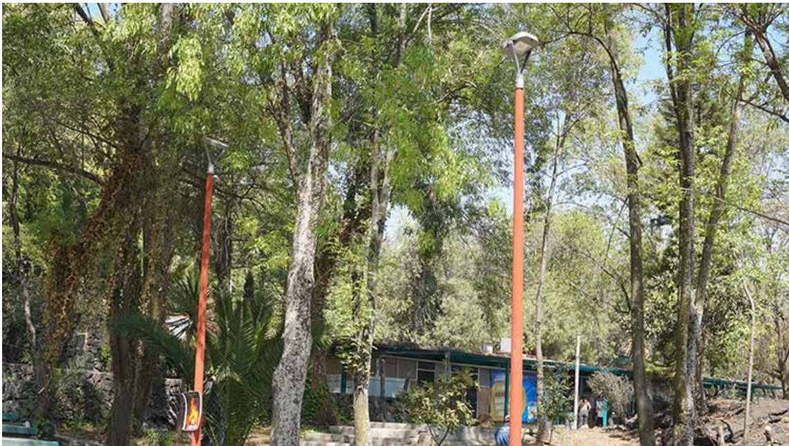
■ COLOCACIÓN de postes en el plantel Sur.
