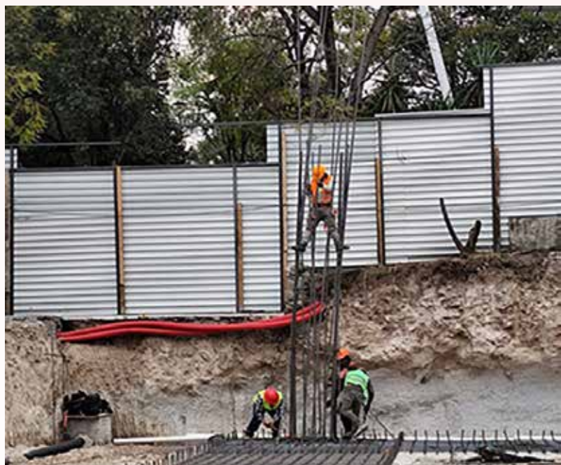
■ CONSTRUCCIÓN de edificio para los Laboratorios Curriculares.
