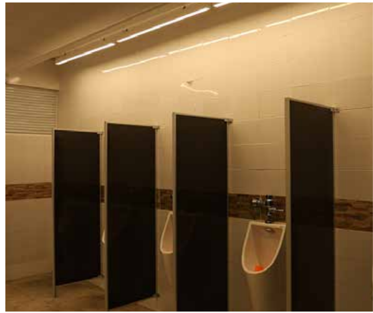
■ NÚCLEO sanitario del edificio O.
