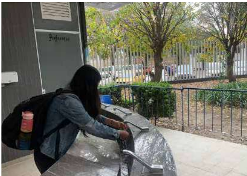
■ NÚCLEO sanitario del edificio L.
